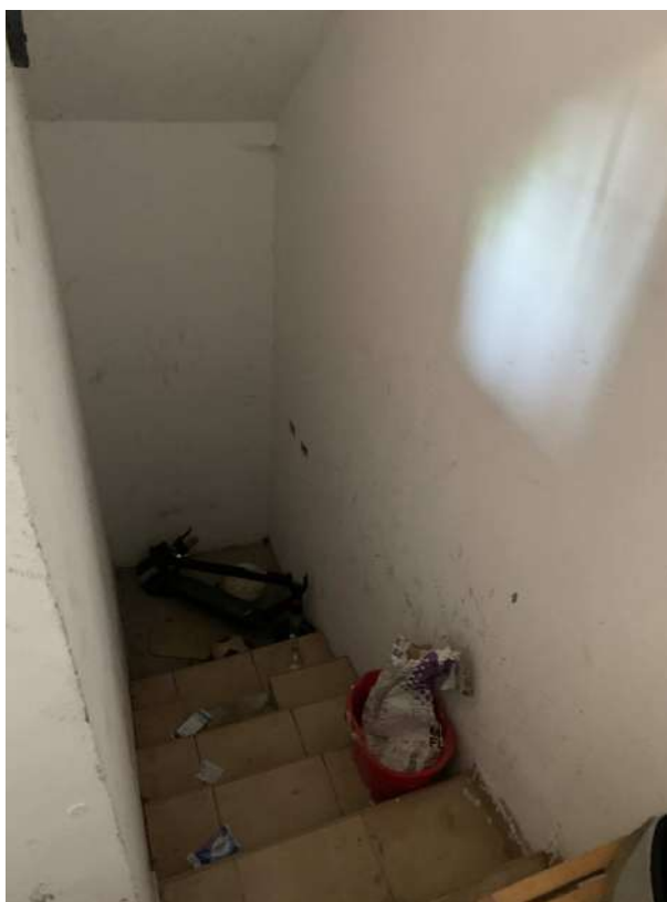
FOTO N.25 porta murata verso interrato
