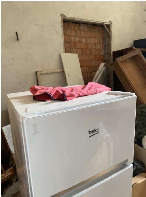
FOTO N.28 porta murata verso su. 536
