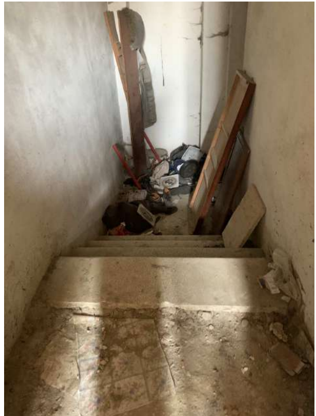
FOTO N.27 scala verso piano interrato
